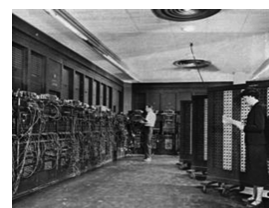
ENIAC: mítica màquina de primera generació construïda amb tubs de buit
